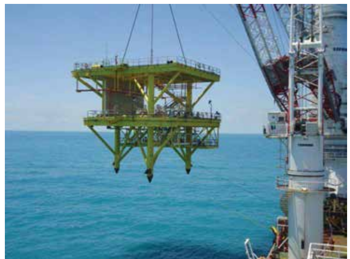
Izaje de subestructura (Tripode) y superestructura (Deck).
