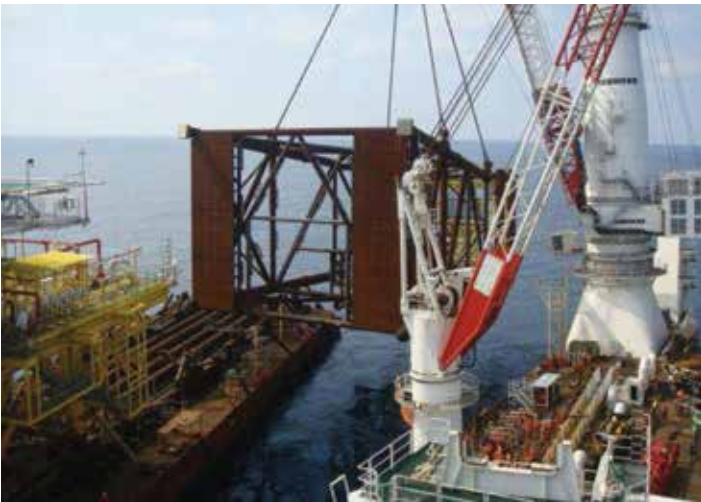
Trípode (Subestructura y Superestructura)
