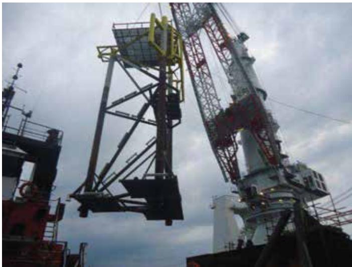
Izaje de subestructura (Tripode) y superestructura (Deck).
